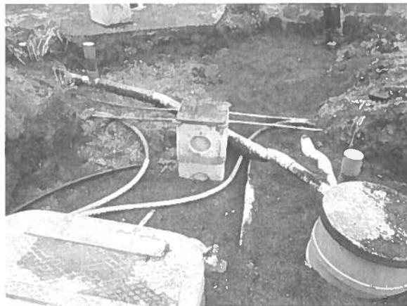
Cette installation a dû faire l'objet de contrôles réglementaires de la part du SPANC, notamment à la fin des travaux, a dû être effectué un contrôle de bonne exécution de celle-ci lors d'une visite sur le chantier avant le remblayage.
