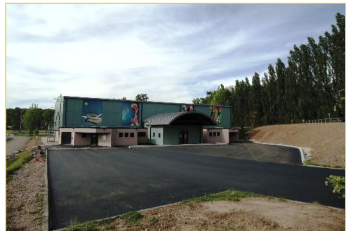
Gymnase : les travaux s'achèvent : goudronnage du parking
