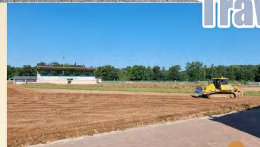
Les travaux sont en cours. La réunion de chantier a été l'occasion de réaliser un point technique et un état du planning de réalisation. Les terrassements sont finis avec des essais de portance largement au-dessus des valeurs imposées par le cahier des charges.
