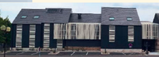
Le bâtiment Ceyrac équipé de vanelles pour se protéger du soleil
