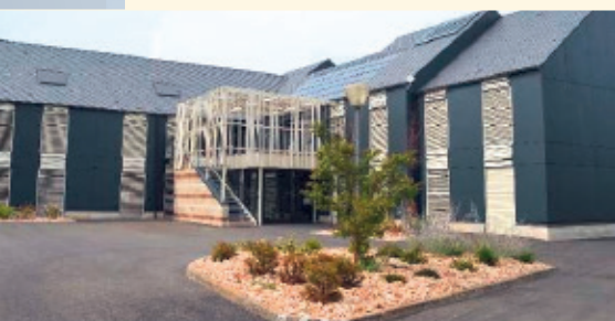
Le bâtiment Ceyrac bénéficie d'un équipement innovant avec les panneaux photovoltaïques
