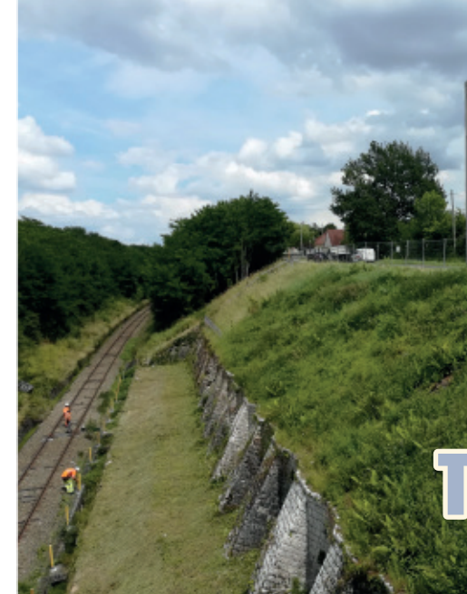
Travaux de chaussée à Audeguil
