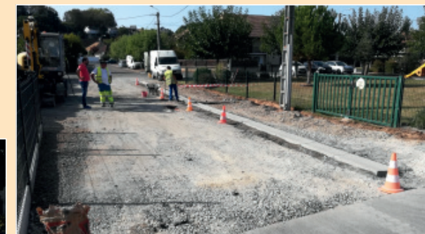
Aménagement de l'allée technique de la cantine du Bourg et de l'espace Charles Ceyrac
