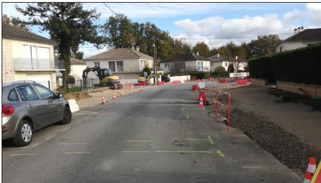
Chantier du lotissement Vézéra-Galandy
