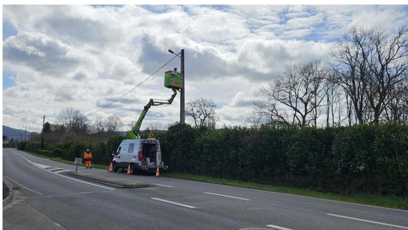
Depuis une semaine l'entreprise INEO procède au remplacement de l'ensemble des points lumineux du parc d'éclairage public vétuste par des appareillages LED fabriqués à Malemort. Cela représente au total 435 luminaires.
